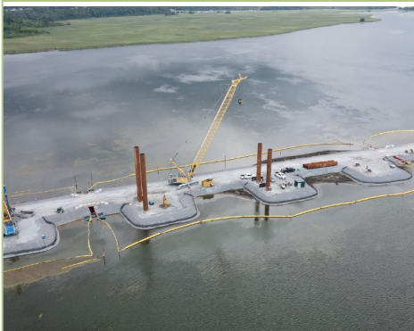
Septembre 2020 (Drone de la ville de Kingston)
